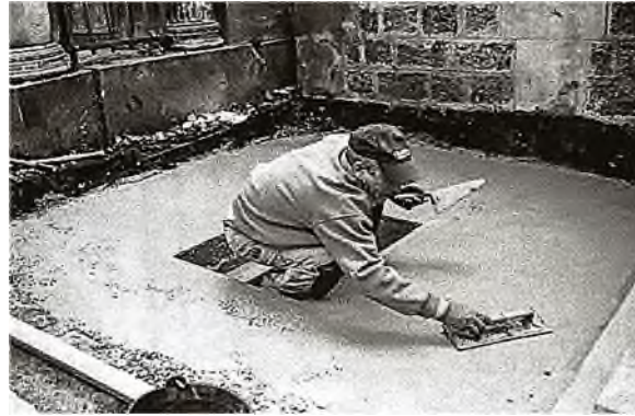
sluiting van de kelder met een zerk / fermeture du caveau avec une dalle
