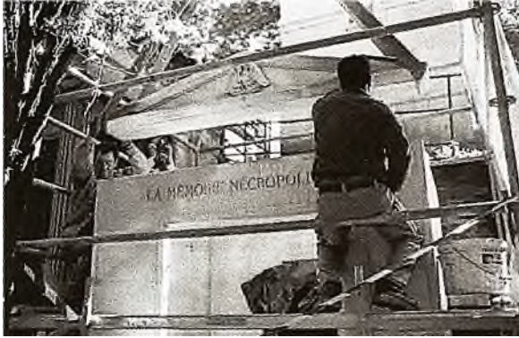
plaatsing van fronton en dak / pose du fronton et du toit
