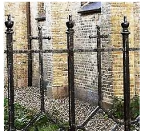
hekwerk voormalige begraafplaats
